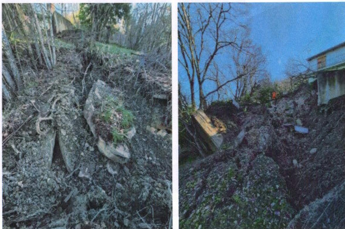
[Figura n. 4 – A sinistra: scivolamenti che dislocano il substrato roccioso; A destra: rottura di opere di contenimento terre in corrispondenza del piazzale antistante il fabbricato civile]
