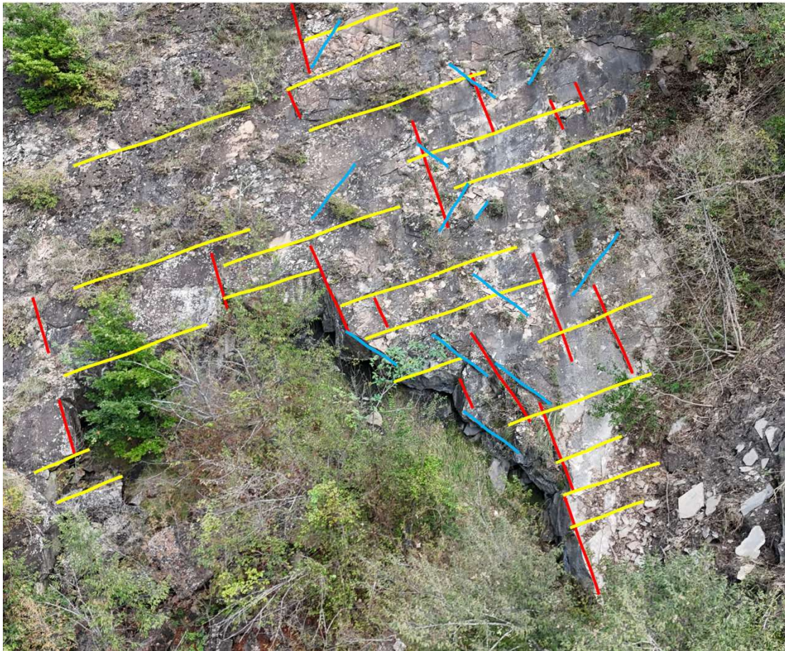
Figura 7: Prospetto fotografico raffigurante la distribuzione spaziale dei principali piani di discontinuità.
